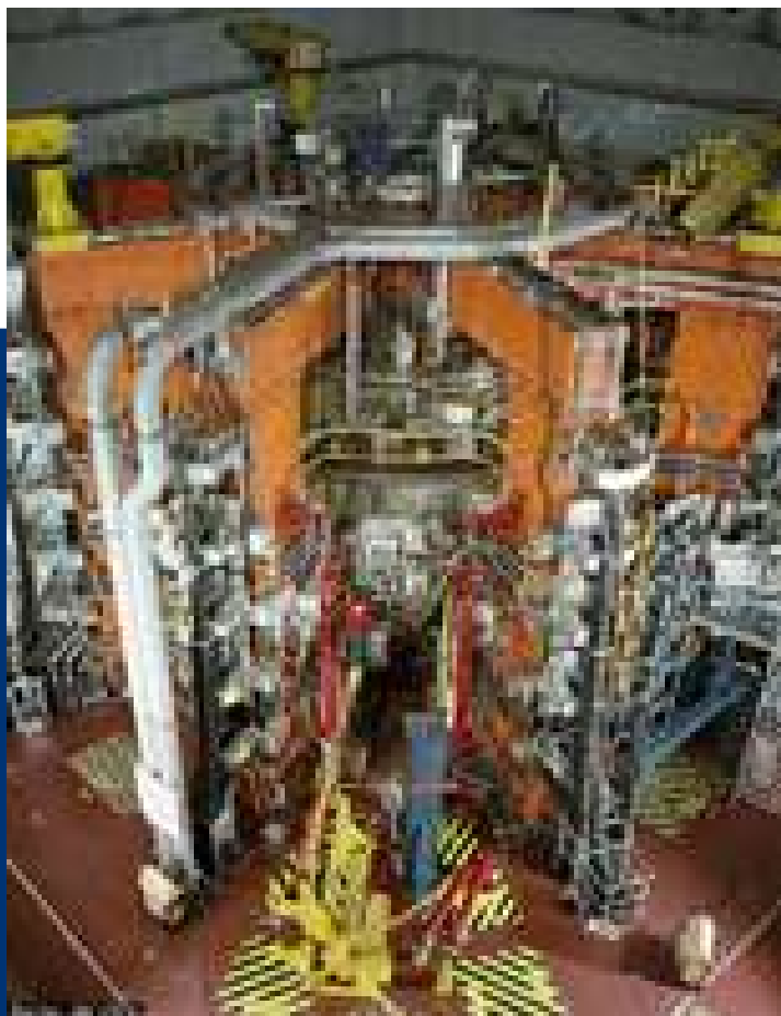
El tokamak JET durante la fase de construcción http://www.jet.efda.org/
