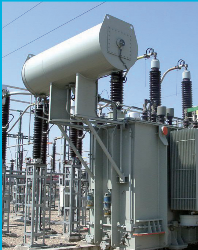
"Transformador de distribución": Desarrollo de sistemas de monitorización en tiempo real y diagnóstico del estado del aislamiento en transformadores de distribución
