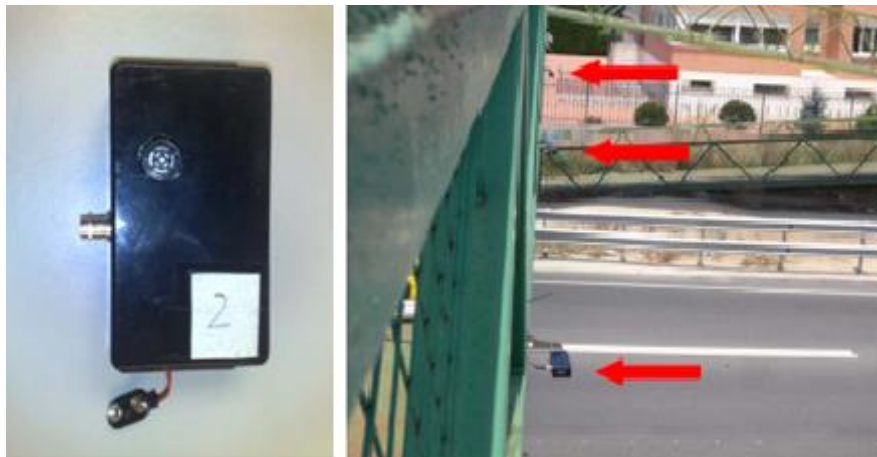
Módulo de medida e instalación sobre un puente
