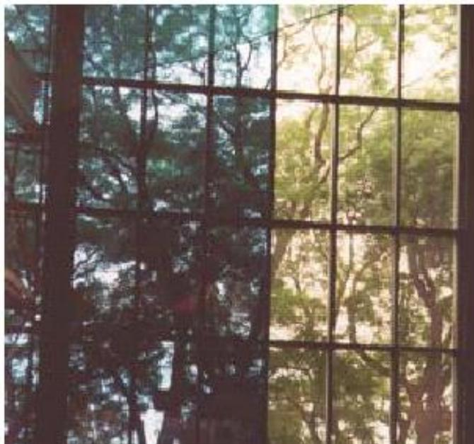
*Vista de la cara sur de una porción de 8 x 17 m de la ventana electrocrómica E-Control fabricada por la empresa alemana Flabeg. La parte izquierda de la ventana está coloreada.*
