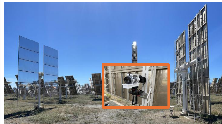
Ensayo en entornos relevantes (planta solar)
